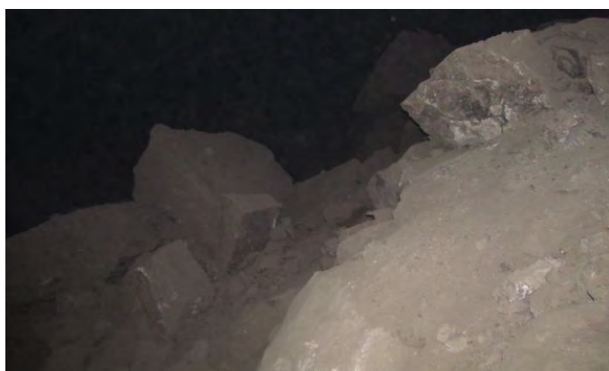
Рис. 6. Підшва порожнини над skleпінням стійкої рівноваги складена матеріалом від зруйнованих ціликів другого і першого горизонтів, міжгоризонтної стелі, водозахисної сетеліни та вміщуючих порід
