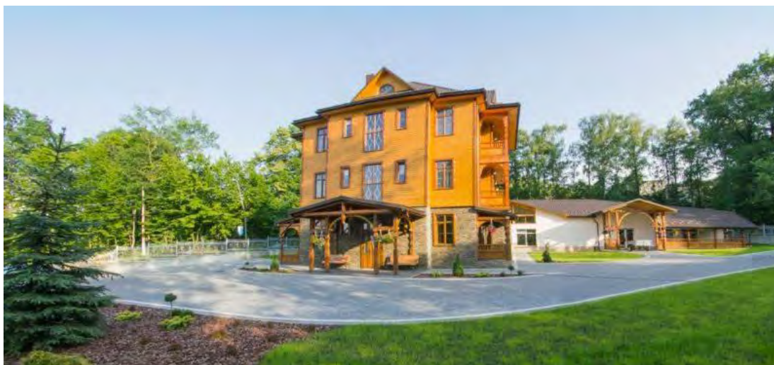
Рис. 4. Ділянка забудови готелю «Жива роса» у 1-й ЗСО, на віддалі кількох десятків метрів від водозабірних свердловин ділянки «Нафтуся»
