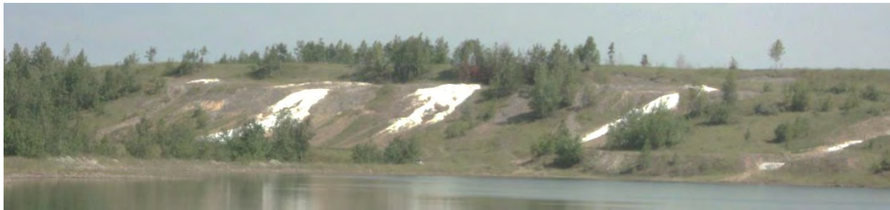
Рис. 2. Північна дамба хвостосховища № 1. Біле – відкладення мірабіліту в місцях витоку розсолів
