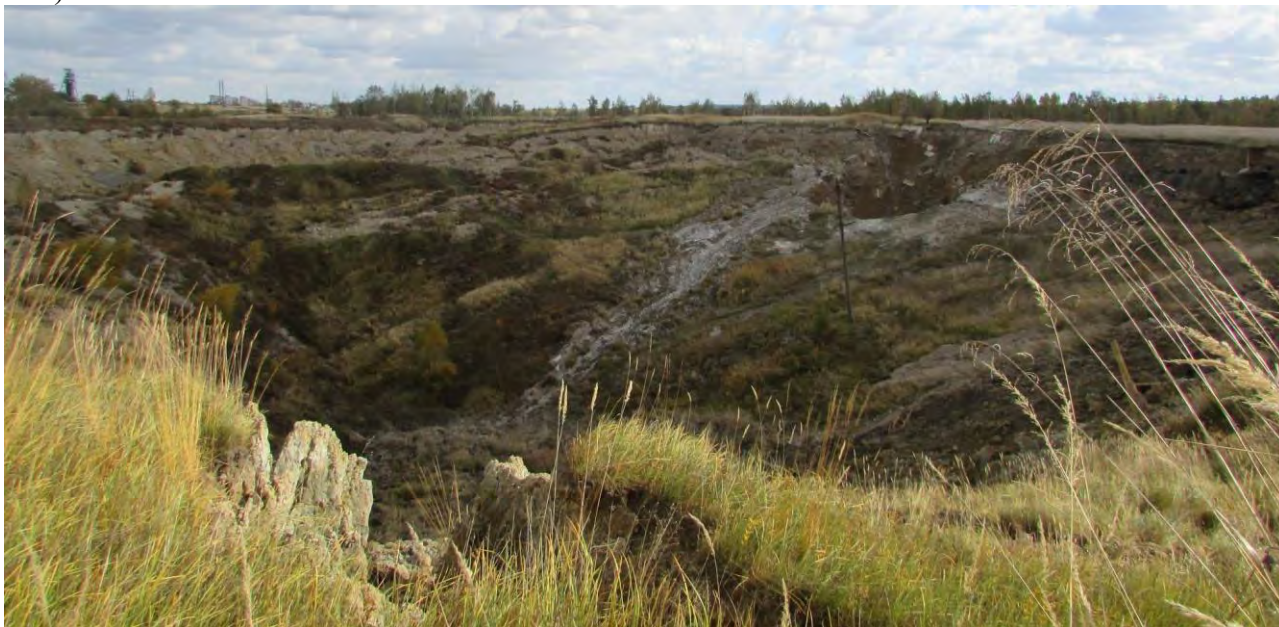
Рис. 1. Провал на пласті № 10 Пд-Сх рудника № 2 Стебницького ГХП «Полімінерал» в районі камер № 108-109-110-111-112-113, який стався 30 вересня 2017 року, 0 годин 46 хвилин
